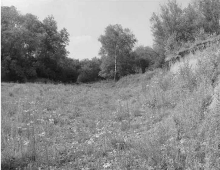
Erosiegeul in het zuidelijk deel, ontstaan na hoogwater in 2000
